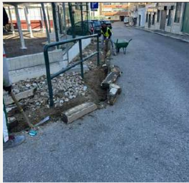
Requalificação do circuito pedonal da zona do Mercado da Cruz de Pau
