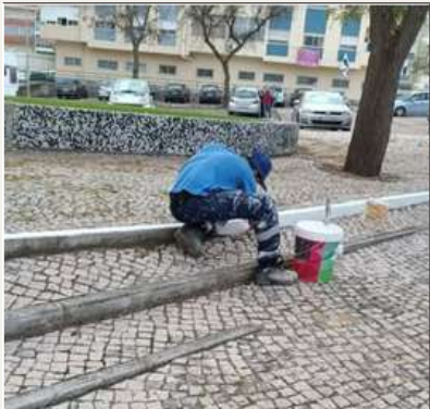
Pintura de escadas e muretes na Avenida Marcos Portugal
