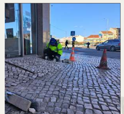
Colocação de rampa na Rua Foros de Amora
