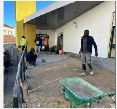
Requalificação da entrada da Associação de Reformados do Fogueteiro (ARPIF)
