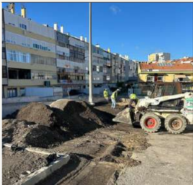
Requalificação de estacionamento e construção de ilha para contentores no Mercado da Cruz de Pau
