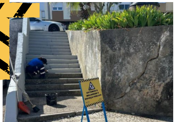
Rua Bordalo Pinheiro, reparação e pintura das escadas e dos muros de sustentação do pequeno jardim
