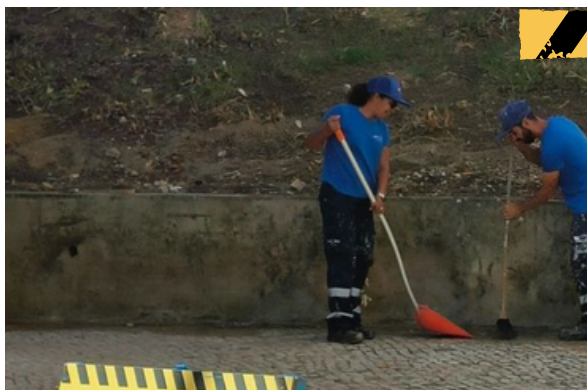
Limpeza dos muros de sustentação da área envolvente à EB Pedro Eanes Lobato e Av. Marcos Portugal
